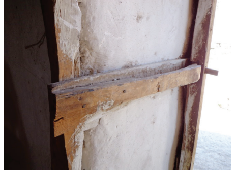
Fotoğraf 12: Yavaşların Odası, ahşaptan kapı kilit düzeneği.
